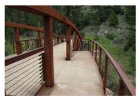
FIGURE 6 TRUSS WITH OUTBOARD PLATFORM
