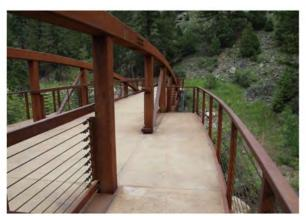
FIGURE 6 TRUSS WITH OUTBOARD PLATFORM
