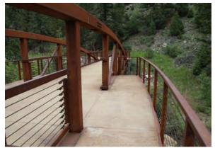
FIGURE 6 TRUSS WITH OUTBOARD PLATFORM
